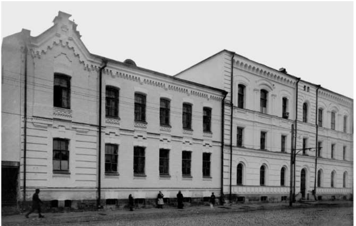
Рис. 14.а. Здание по ул. Трехсвятская 31/16.
