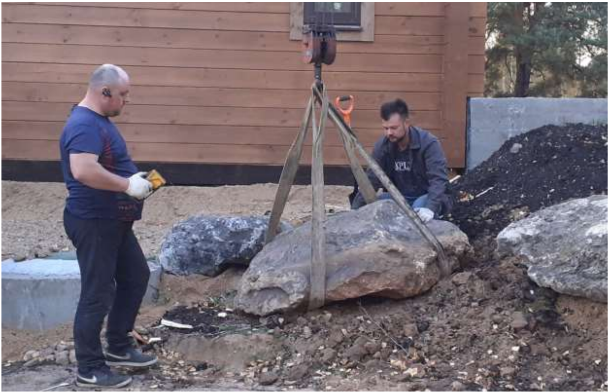
Рис. 9. Укладка степняков на объекте
